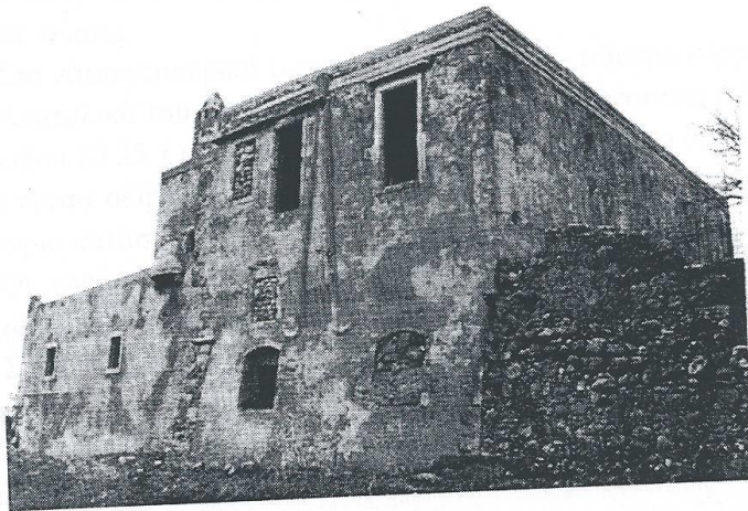
Η νότια πλευρά του Κονακιού, πριν την τελική ανασύλωσή του.
