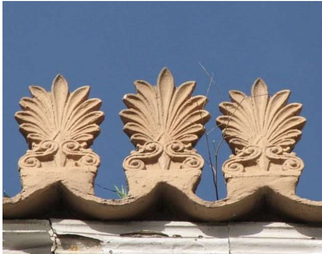
Εικ.52. Ανθέμιο σε ακροκέραμο αρχαίου κτηρίου που συμβολίζουν φύλλα φοίνικα
