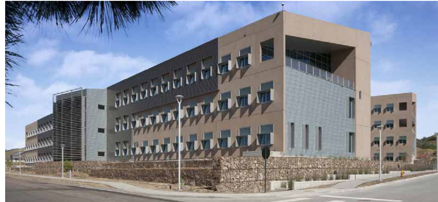
Εικόνα 10 The Research Support Facility, Golden, Colorado. Το Research Support Facility (RSF) είναι ένα LEED Platinum κτίριο που ενσωματώνει μια σειρά από πράσινες καινοτομίες, όπως το ηλιακό σύστημα θέρμανσης του αέρα της SolarWall που διαθέτει. Φωτογράφος: Frank Ooms
