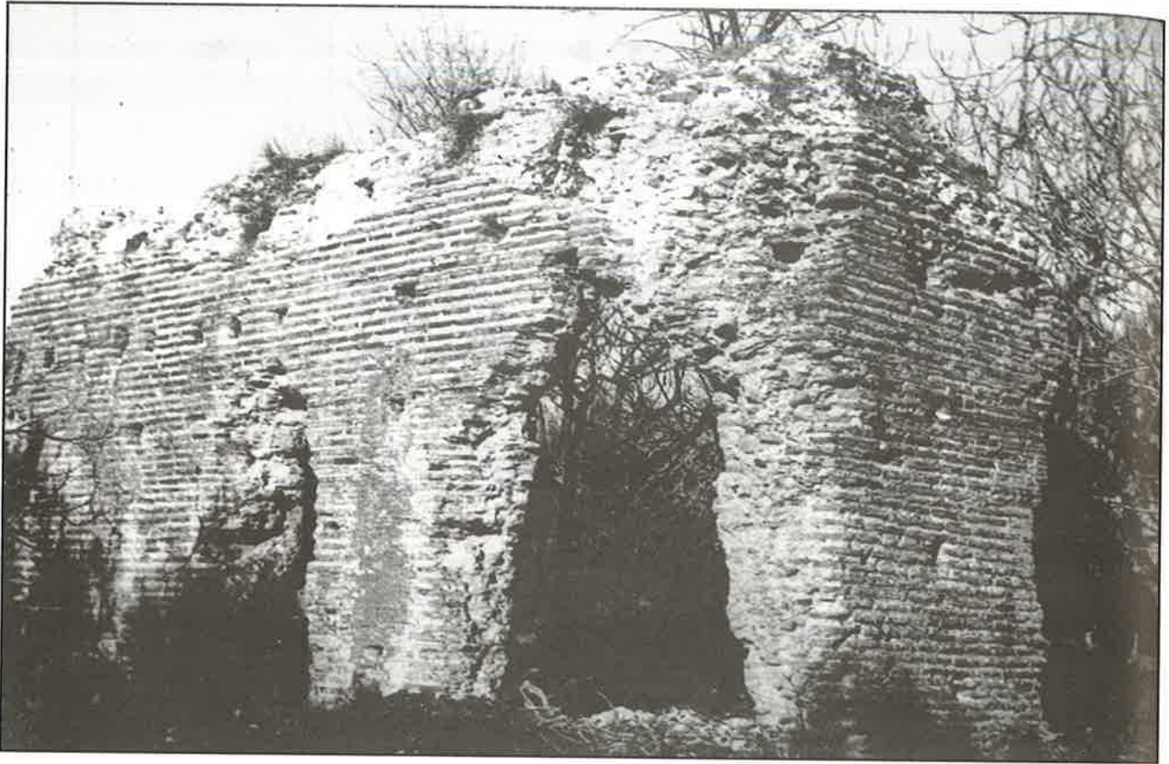
Εικ. 1 Νότια και ανατολική άποψη του μνημείου.
