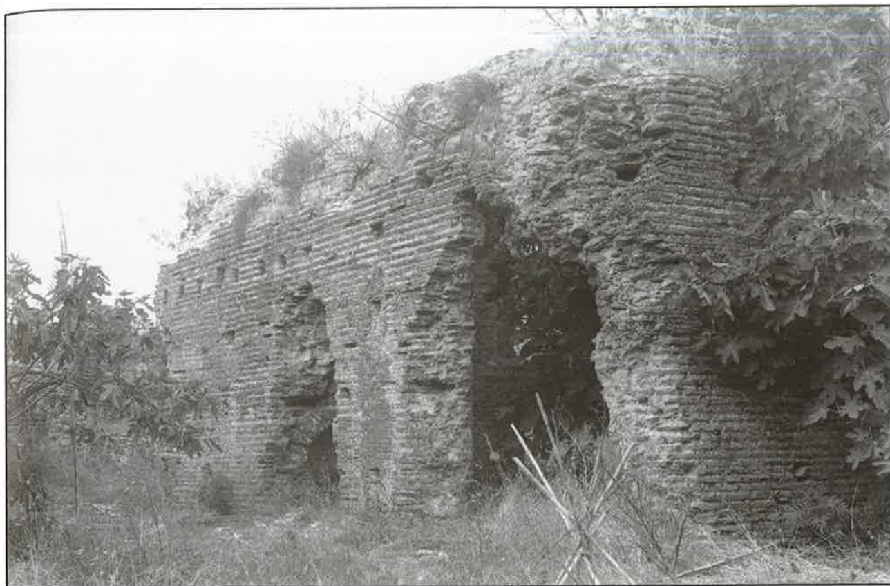
Εικ. 3 ΝΑ άποψη του μνημείου.
